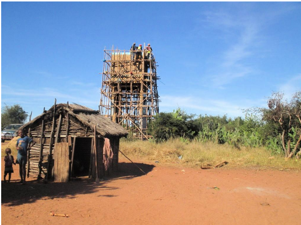
Wasserturm mit Gerüst
