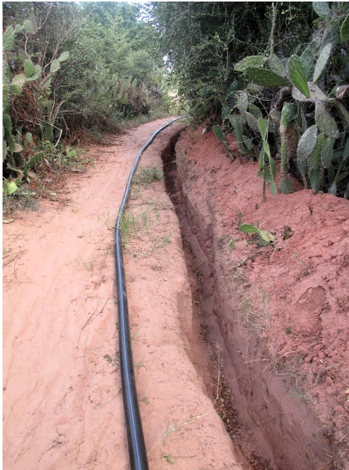
Die Verlegung der Wasserleitung zur Versorgung der weit zerstreute Dörfer wurden von den Einwohnern durchgeführt.
