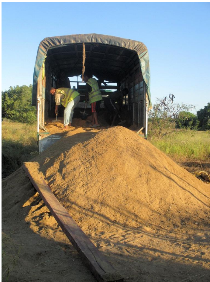
Die Versorgung der Baustelle mit Baumaterial ist schwierig
