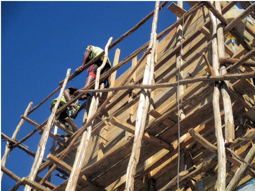
Gerüst des Turms
